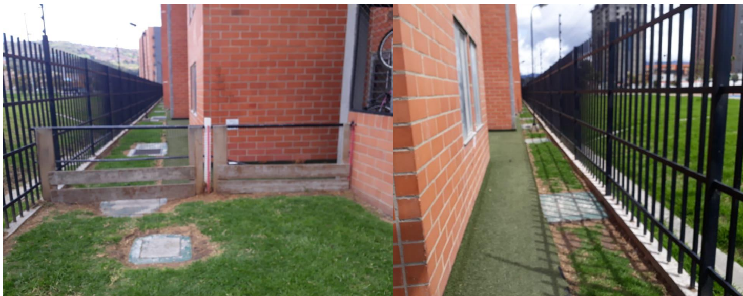
Torre 4 y zona de mascotas
